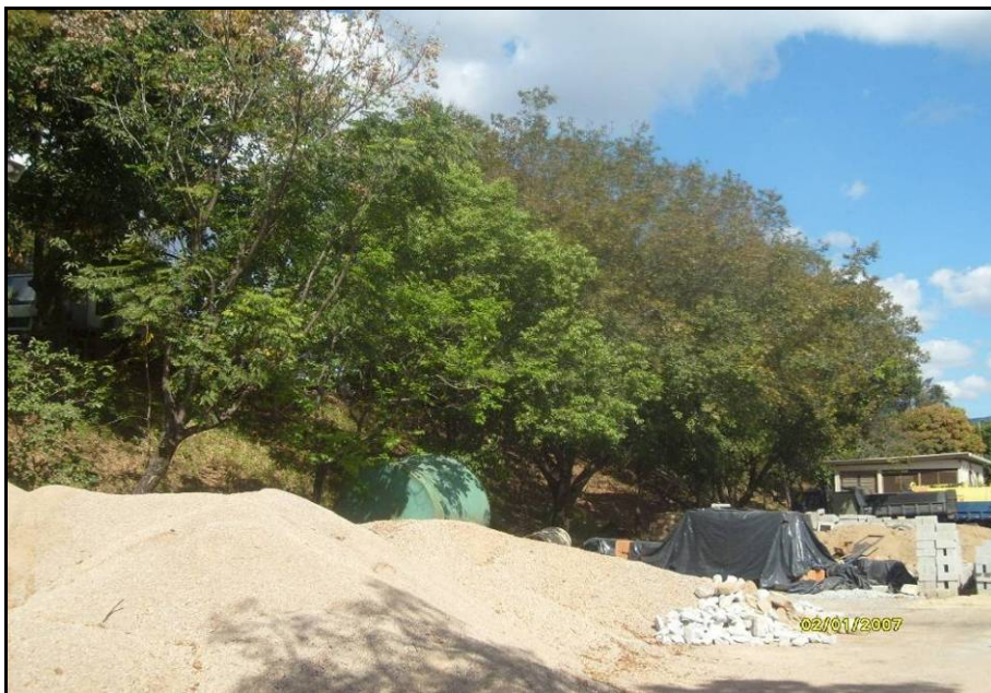
Figura 34. Presença de árvores enfileiradas ao longo do talude.
