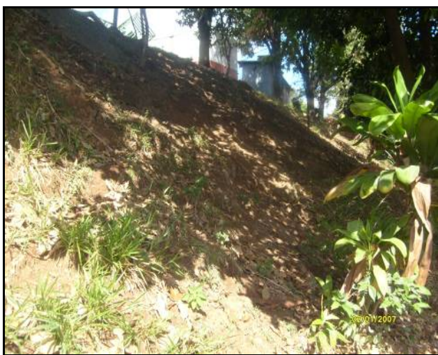
Figura 117. Foto demonstrando um talude com plantio espaçado de gramíneas, necessitando de fomento e manejo intensivo.
