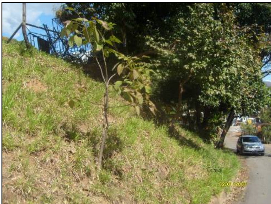
Figura 31. Vista parcial de um talude revegetado com gramíneas e algumas plantas arbustivas na porção inferior da propriedade.
