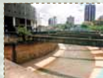
01) Trecho do Ribeirão Arrudas, 1999.
