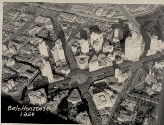
05. Praça Sete, Avenida Afonso Pena, 1954.
