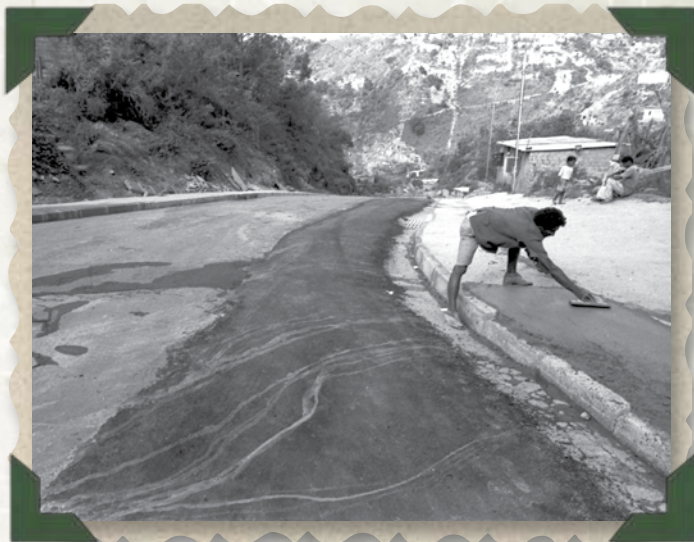
13. Obras na Rua Teixeira dos Anjos, Taquaril, 1995.
