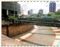
01) Trecho do Ribeirão Arrudas, 1999.
