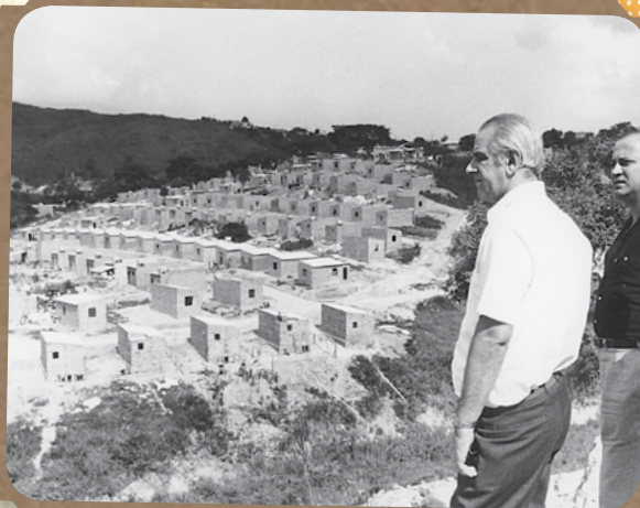
24. Conjunto habitacional em construção na Vila Pinho, década de 1980.
