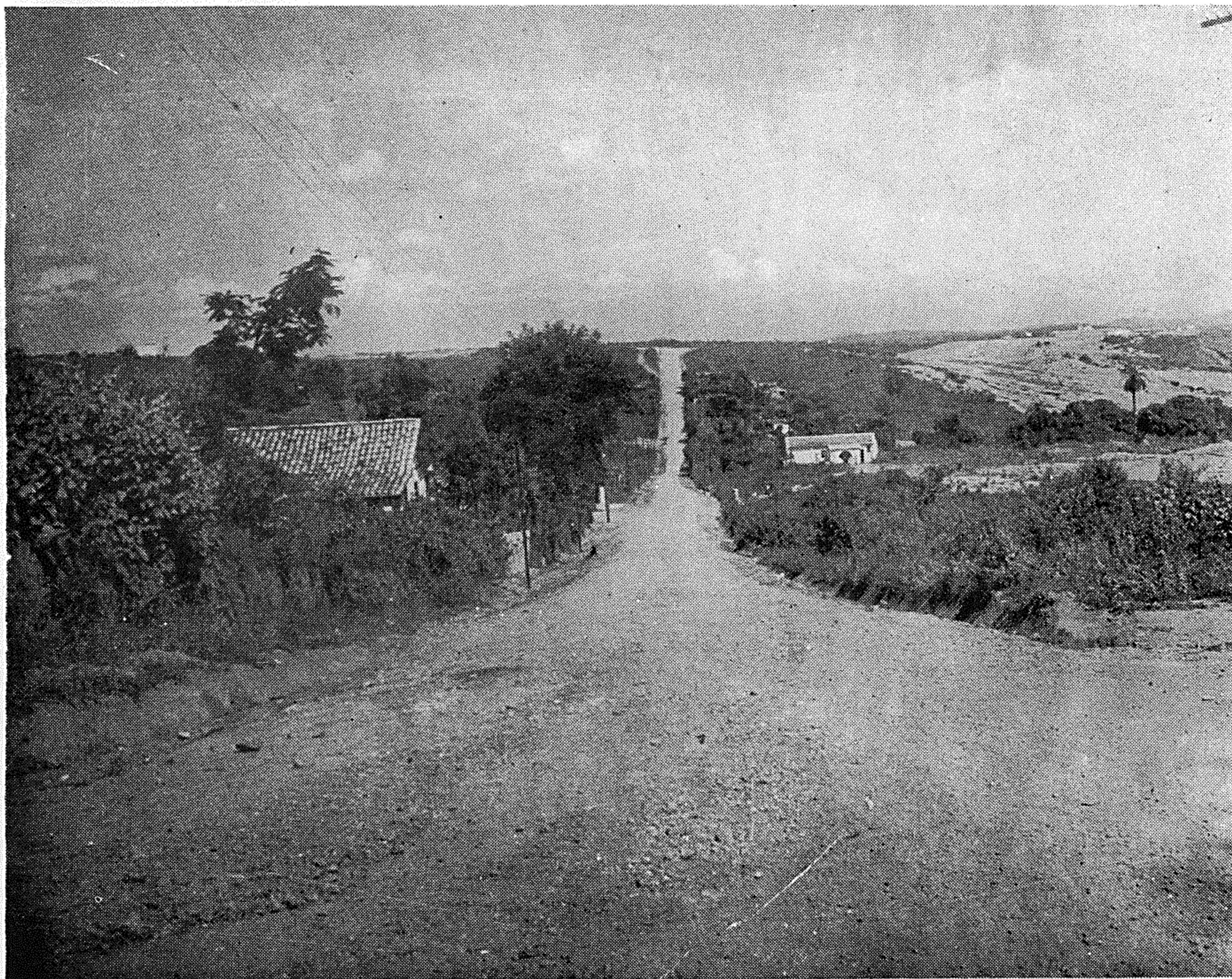
NOVAS RUAS — Cerca de uma centena de ruas foram abertas, dentro do programa de urbanização das vilas e de ligação dos vários núcleos populacionais ao centro. (Vista parcial da Vila São Francisco — Via de acesso ligando a Av. Antônio Carlos ao Q. G. do Exército).
