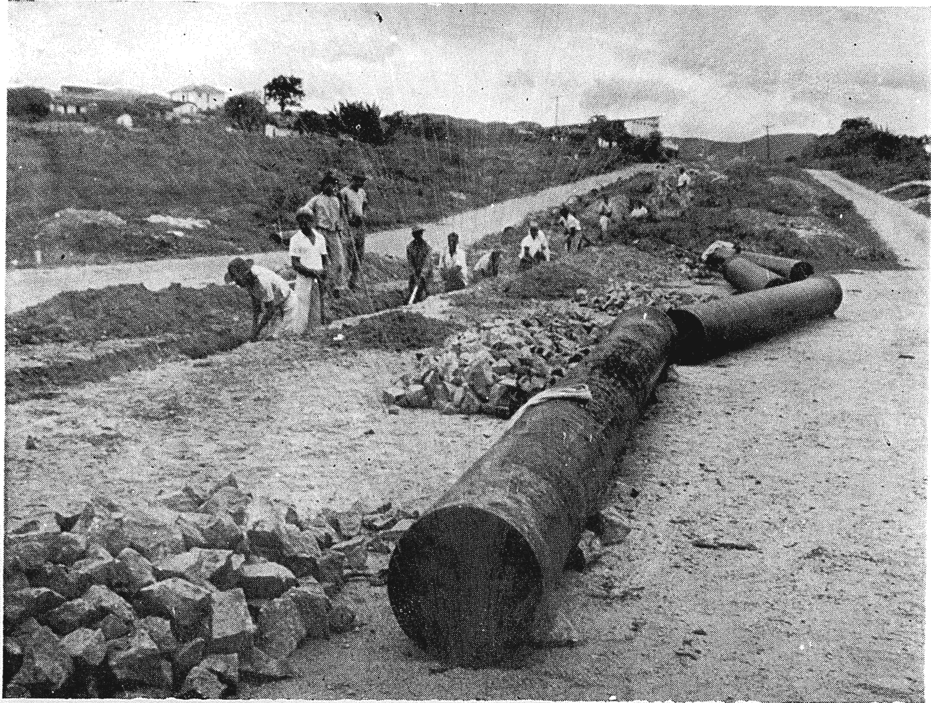
NOVAS SUB-ADUTORAS — Grandes sub-adutoras são construídas para levar água a extensas zonas que jamais contaram com abastecimento regular do precioso líquido.
