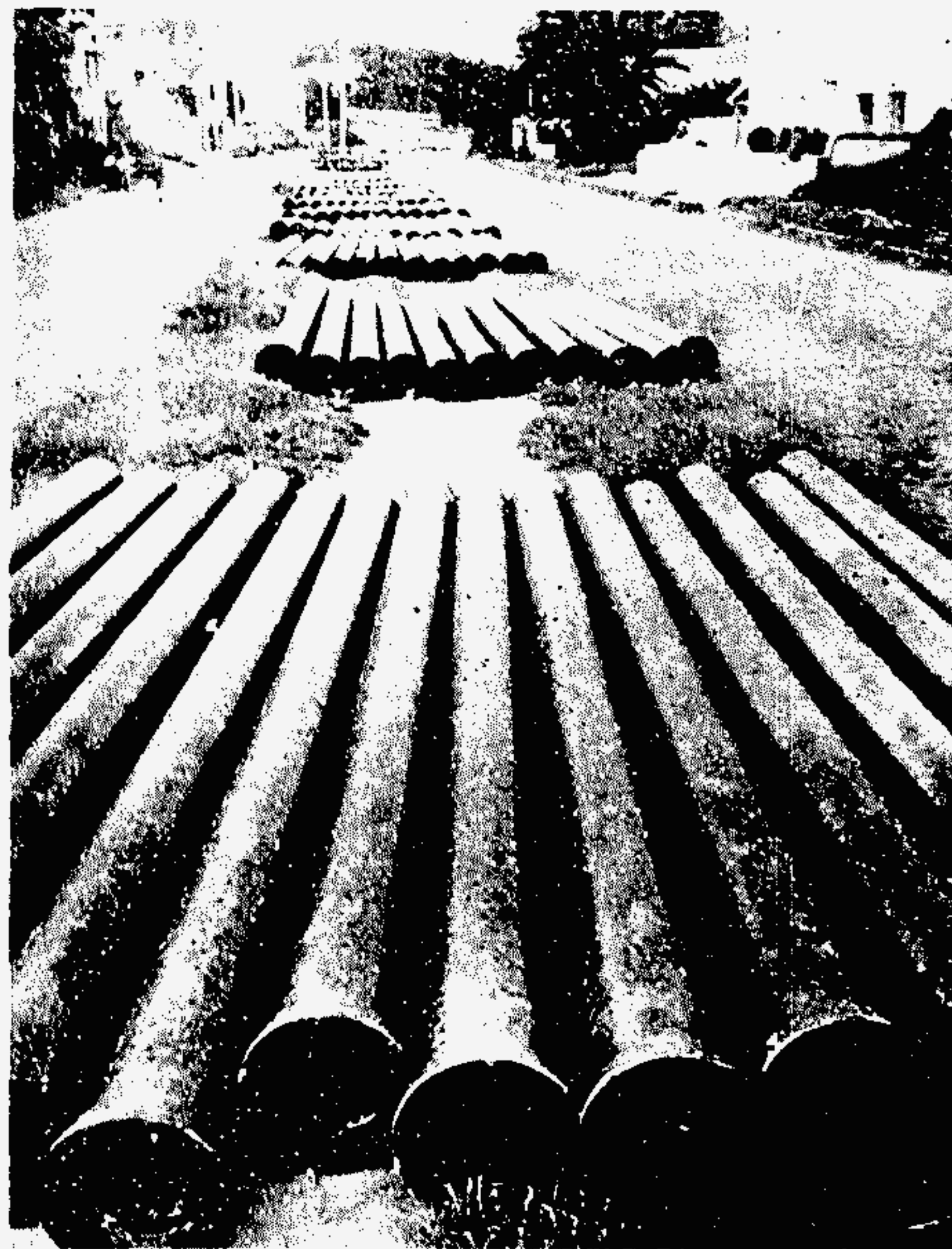
MAIS ADUTORAS — Quilômetros e quilômetros de adutoras e sub-adutoras são construídas para abastecer a Cidade.
