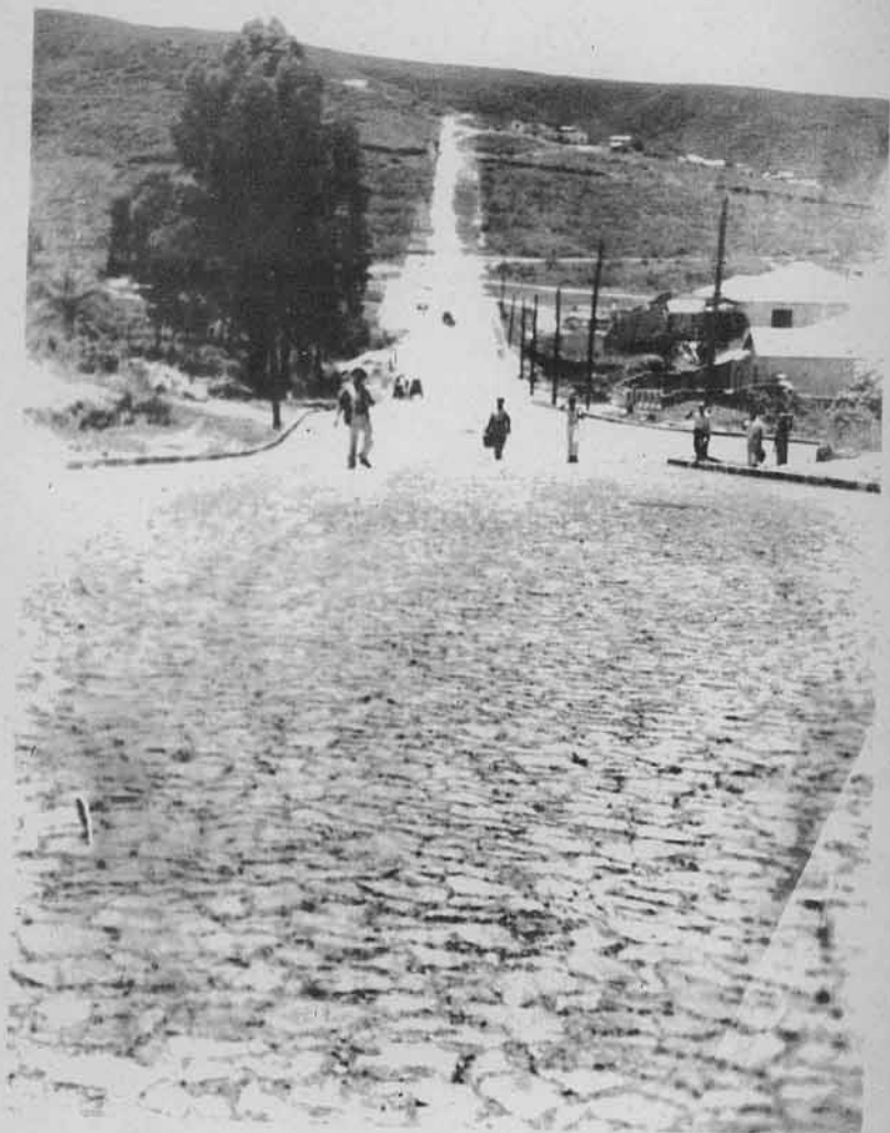
Obras de calçamento a alvenaria na rua Almirante Alexandrino.
