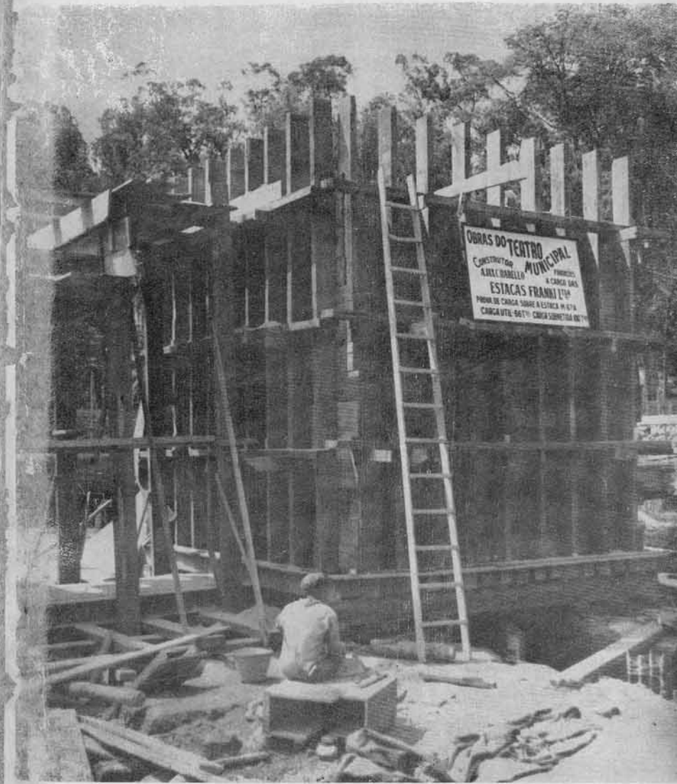
Teatro Municipal — Provas de "carga", sobre as estacas
