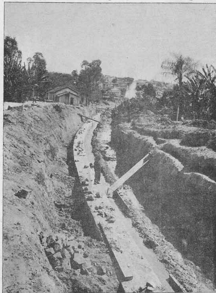
Construção da Avenida Pedro II
